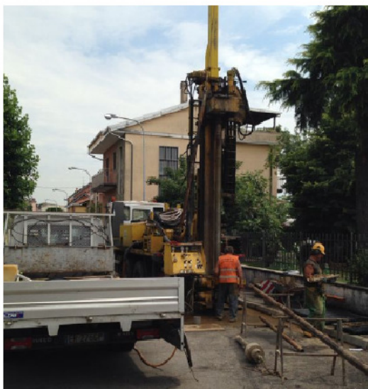
Foto 1. Ubicazione sondaggio geognostico S2
